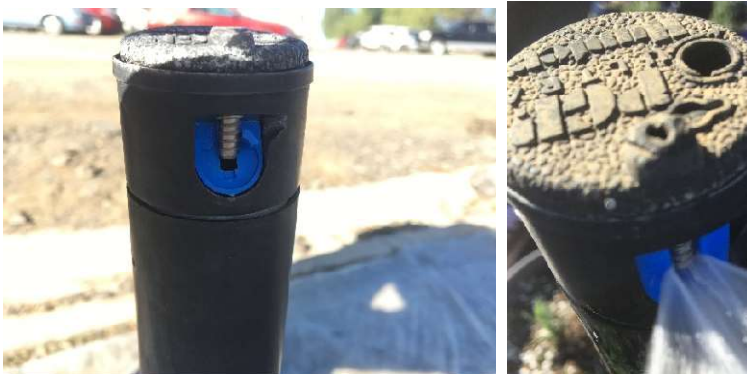
Ilustración 4. Tipos diferentes de boquillas (se vea el numerito impreso de 6 y de 4) en los aspersores instalados en el campo.
