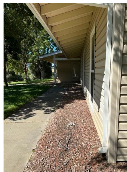
Figura 8: Uso de acolchado de roca alrededor del edificio en la Zona Cero.
