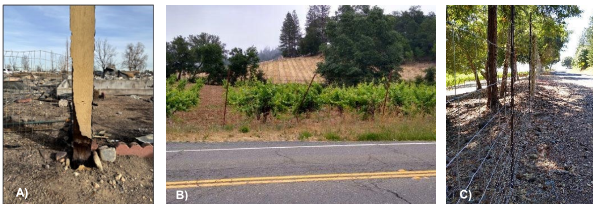
Figura 13: A) Poste de cerca que se quemó, pero el fuego no se propagó debido al material metálico de la cerca. B) Cerca metálica con la línea sin mantenimiento y sin despejar de vegetación, lo que facilita la propagación del fuego. C) Cerca de metal y madera, libre de vegetación y bien mantenida.
