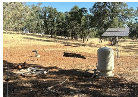
Figura 16: Los pozos y tanques pueden utilizarse para recargar las cisternas y las unidades de bomberos durante un incendio.
