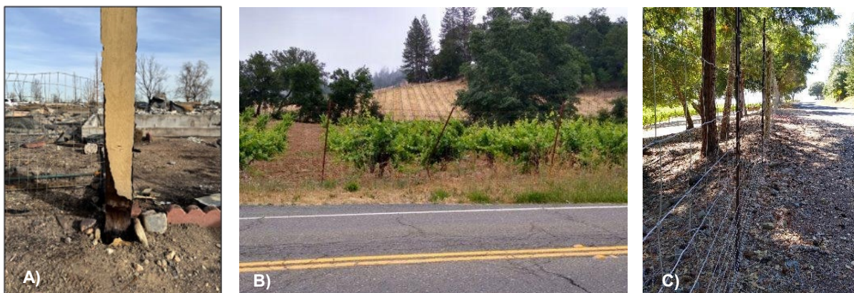
Figura 12: A) Poste de cerca que se quemó, pero el fuego no se propagó debido al material metálico de la cerca. B) Cerca metálica con la línea sin mantenimiento y sin despejar de vegetación, lo que facilita la propagación del fuego. C) Cerca de metal y madera, libre de vegetación y bien mantenida.
