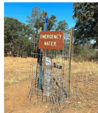
Figura 15: Rotule claramente todas las fuentes de agua de emergencia con señalización reflectante.
